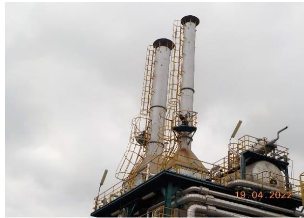
ปล่อง Off Gas Incinerator G-960U
